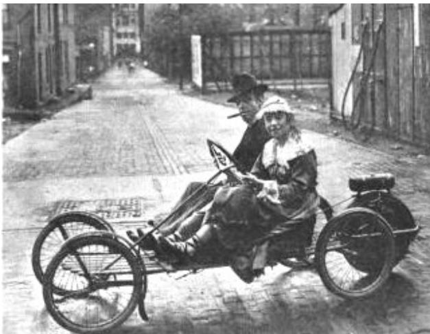
La yuri vendesis a la "Majestic Engineering & Manufacturing Co.", pose konocata kom "Automotive Electric" de la New-Jersey (lando di la USA). Dum kelka tempi, la "Red Bug" movantesis per la kinesma motor-roto, o per la motoro elektrala (12 volt) di la entraprezo Dodge. Fine, la motor-roto kambiesis por motoro de kin povo-kavali, ligata a la dopa roti per kateno.
